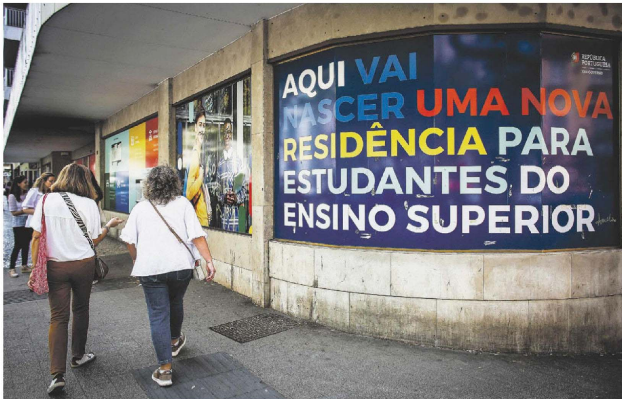
A antiga sede do Ministério da Educação, na Avenida 5 de Outubro, está desocupada há oito anos FOTO NUNO FOX
